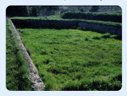
Le minerai se dépose au fond par gravitation. Une grande partie de l'eau est récupérée et renvoyée dans des bassins pour une utilisation ultérieure. Grâce au soleil, le restant d'eau s'évapore.
